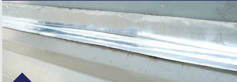
Sudut antara dinding dan atap
